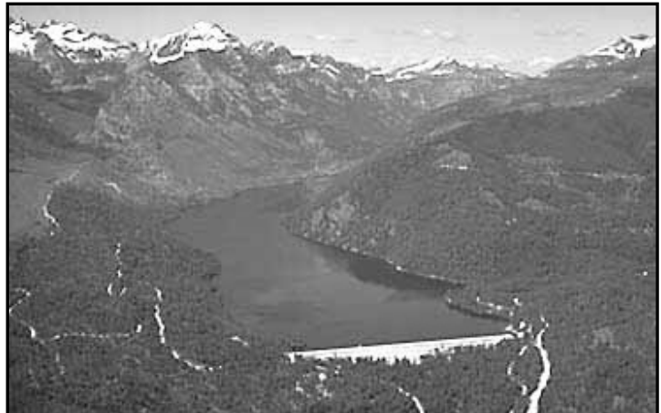
Photo 68. Como Dam. Photo source unknown.
